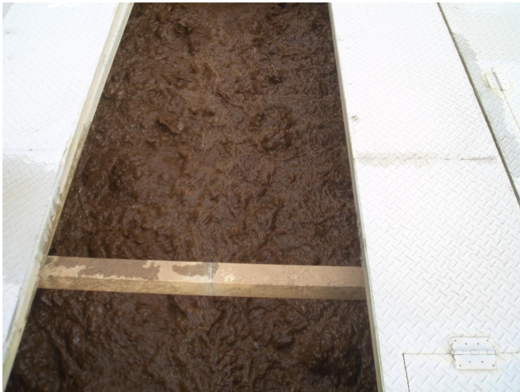
圖 7-2 MBR 生物池內 MLSS 約 15,000 mg/L 曝氣操作情況。
